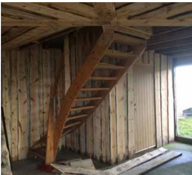
Ny trapp som fører opp til flott utsikt i andre etasje.
