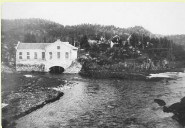
Kringsjø kraftstasjon før den ble revet.
